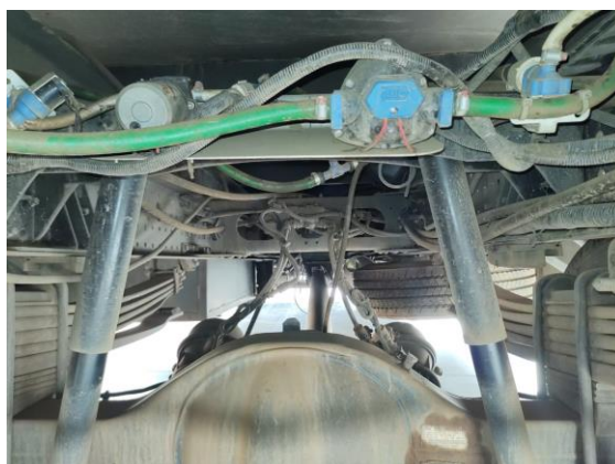
Local de instalação das Bombas d'água
